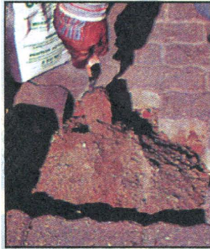
Насыпанный в образовавшуюся выемку песок сгребают к центру.
