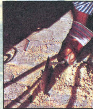
Песок для заполнения швов распределяют по всей поверхности.
